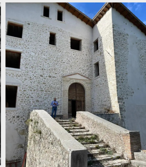
Vizita in santier, pentru masuratori la un castel din Riofreddo, Italy
